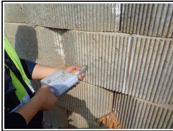
【그림 2.3.6】 슈미트해머를 이용한 반발경도시험 전경
